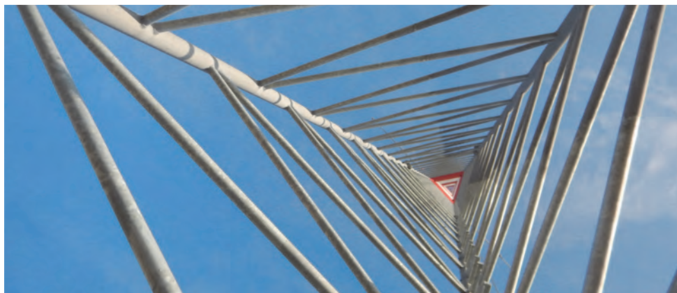
Höchster frei stehender Windmessmast in Norddeutschland
