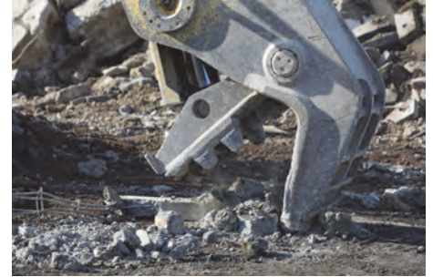
Zerkleinerung von bewehrtem Beton mittels Bagger
