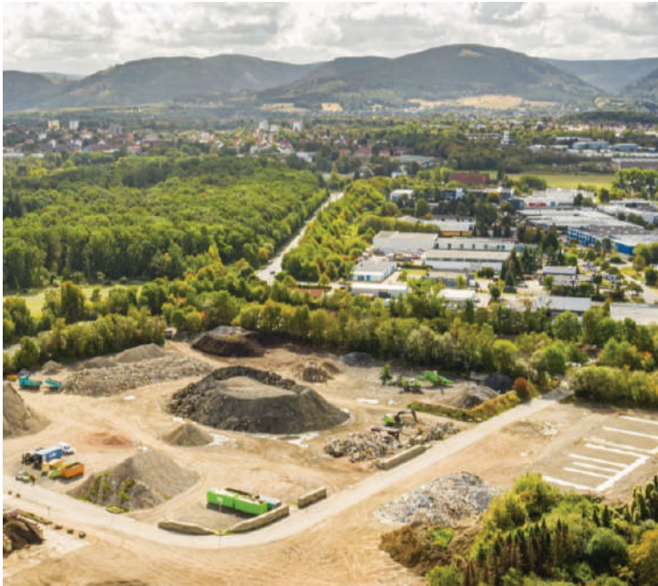
Betriebsstätte Goslar aus der Luft
