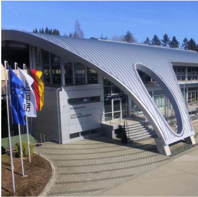
Headquarter am Hauptstandort Clausthal-Zellerfeld
