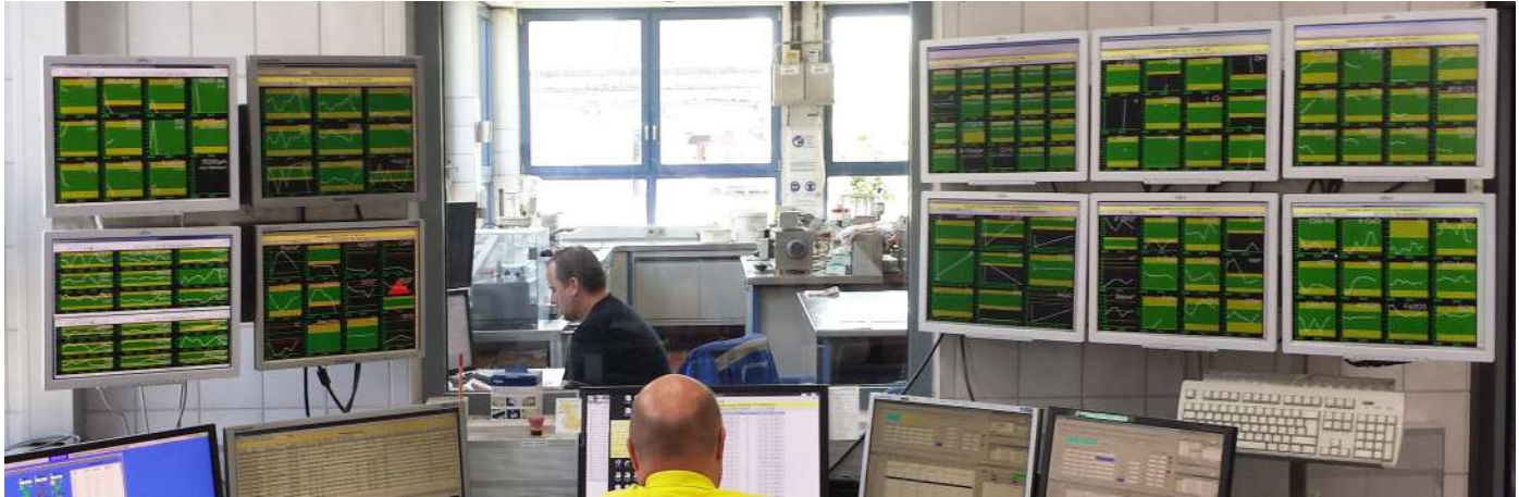
Qualitätsüberwachung im Labor mit Lösungen der pdv-software GmbH (Quelle: Dyckerhoff GmbH)
